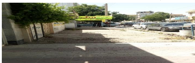
شکل شماره ۴: کفسازی نامناسب
