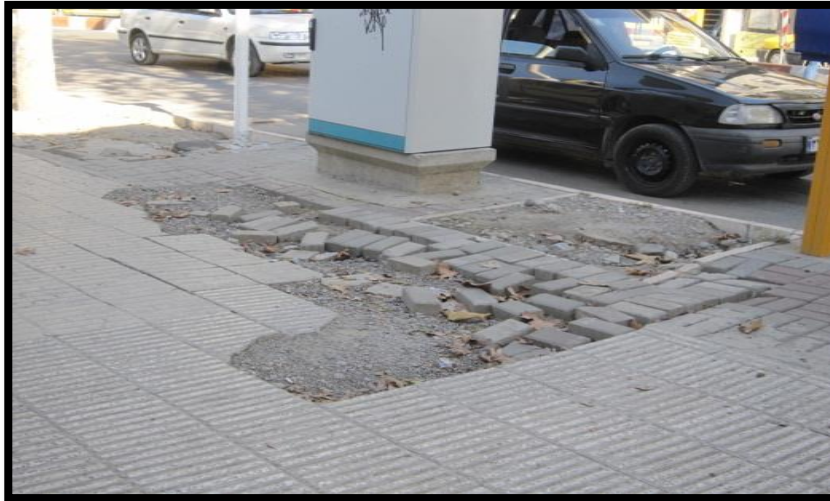
شکل (۲): خرابی و کند شدن سطح پیاده رو، عدالت ۲۹.
